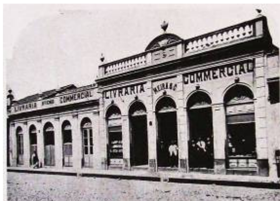
Figura 7 – Fotografia da fachada da Livraria Commercial, detalhe do anúncio publicado no Álbum de Pelotas , 1922.
